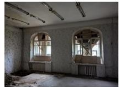
8 нче рәсем. Кат аралары яссы япмалар, тәрәзә уемнарының кирпеч перемычкалары
