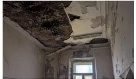
11 нче рәсем. Кат аралары яссы япмалар, тәрзә уемнарының кирпеч перемычкалары
