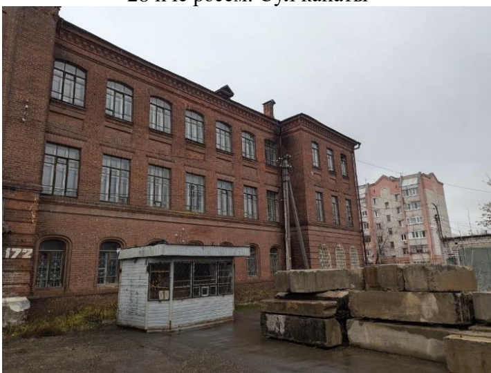
29 нчы рәсем. Уң канат. Тәрәзә уемнарының конфигурациясе, урнашу урыны
