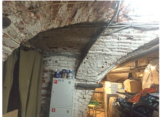
Подвал бинасында жээлмәле кирпич цилиндрлы гөмбөзлөр
