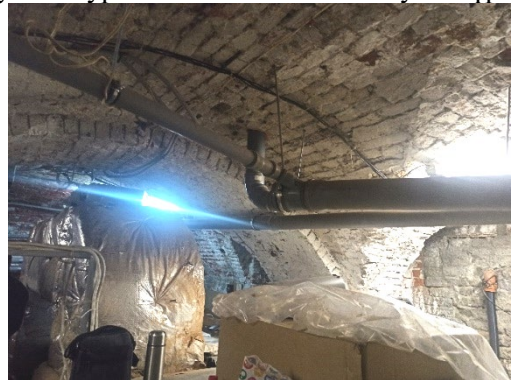
Подвал бинасында жәелмәле кирпич цилиндрлы гөмбәзләр
