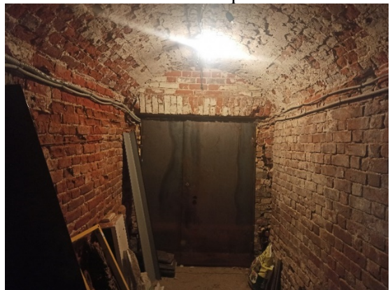
Подвал бинасында жээлмәле кирпич цилиндрлы гөмбөзлөр
