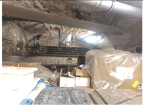
Подвал бинасында жээлмәле кирпич цилиндрлы гөмбөзлөр
