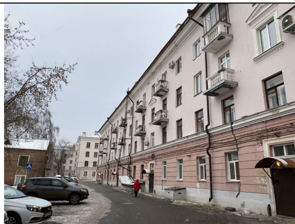
Көнъяк фасад күренеше
