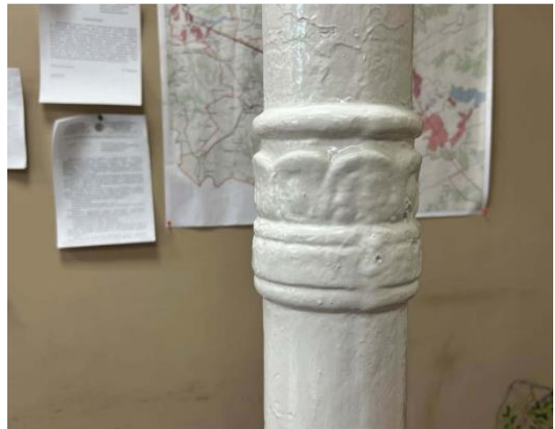
17 нче-18 нче рәсемнәр. Бизәкле һәм фигуралы металл терәк колонналар
