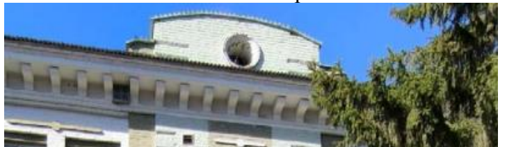
9 нчы рәсем. Икенче катның тэрээ уемнары өстендә уртада түгэрэк булган тар ак таш таякчыклар
