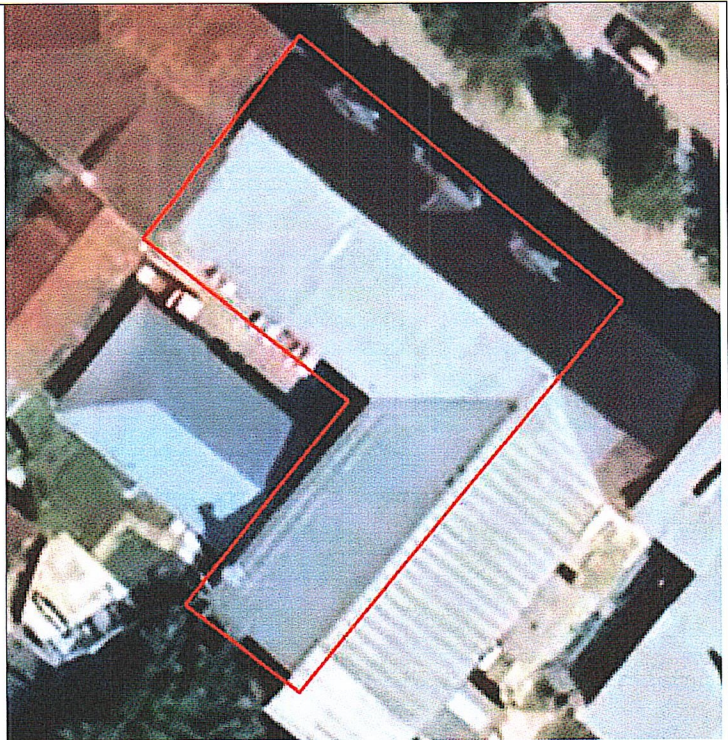
Рис. 3. Крыша объекта культурного наследия
