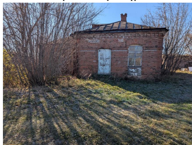
10 нчы рәсем. Төньяк-көнчыгыш фасад
