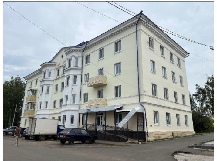
26 нчы рәсем. Төп фасад балконнары.
