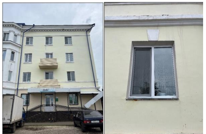
12 нче-13 нче рәсем. Фасад пластикасы, билбаулар, йозак ташы.
