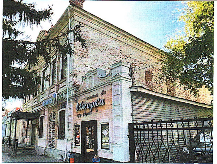
Рис.8. Вид на крышу со стороны Главного фасада
