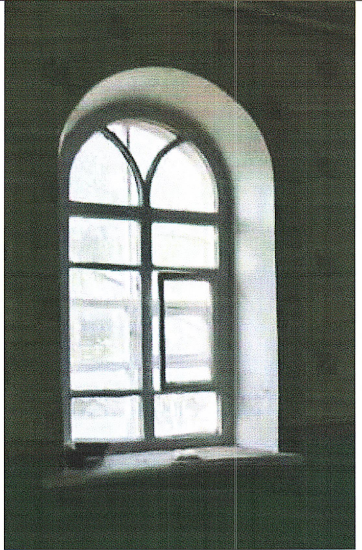
Рис. 11. Окно в помещении второго этажа
