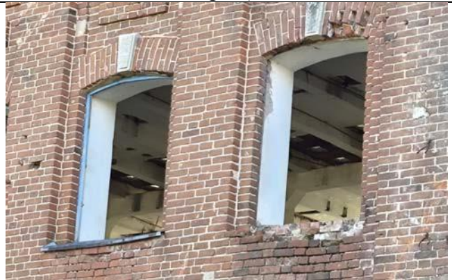
9 нчы рәсем. Штукатурсыз кирпич өеме
