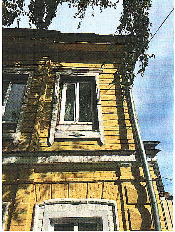
Рис.13. Оконные проемы, пилястры, карнизы
