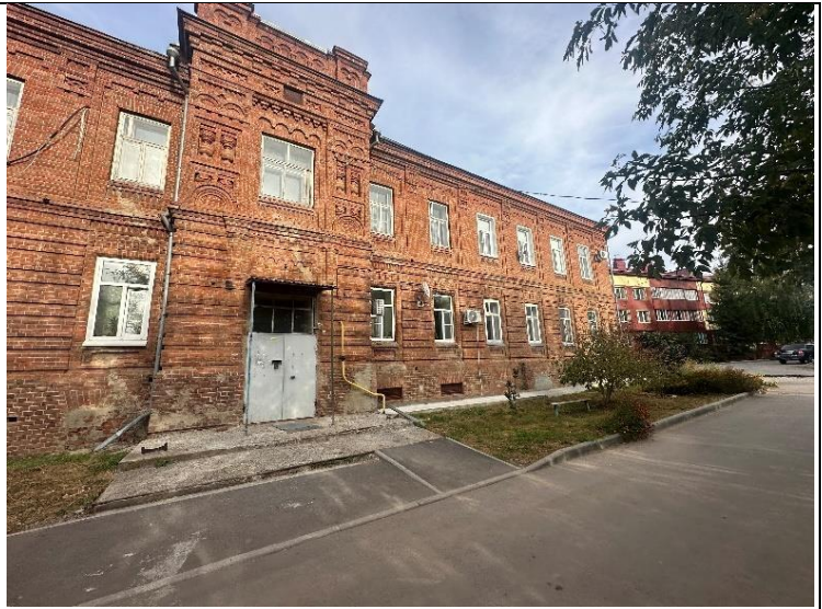
11 нче рәсем. Көнъяк-көнбатыш фасад фрагменты
