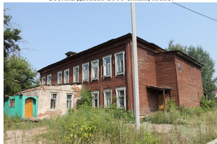
11 нче рәсем. Көнъяк-көнчыгыш (ишегалды) фасады. Съемка датасы: 2016 елның июле.
