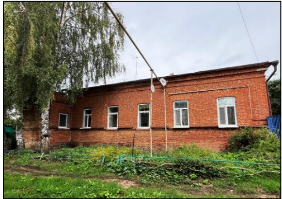
10 нчы рәсем. Көнбатыш ишегалды фасады. Тәрзә жәяле перемычкалы уемнар
