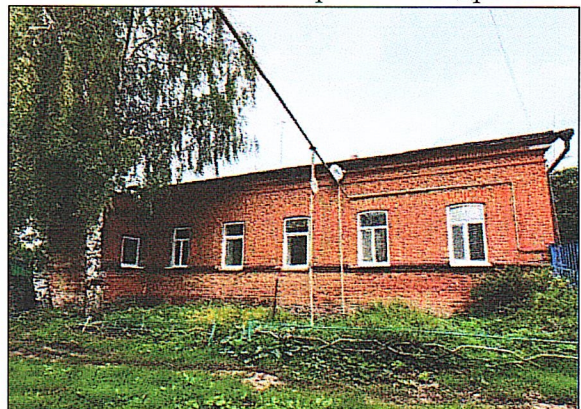
Рис.11. Западный дворовой фасад. Оконные проемы с лучковыми перемычками
