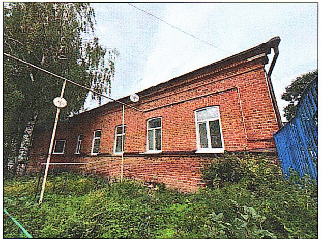
Рис.16. Оконные проемы. Западный дворовой фасад
