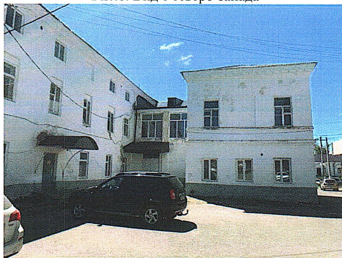
Рис.9. Вид с севера
