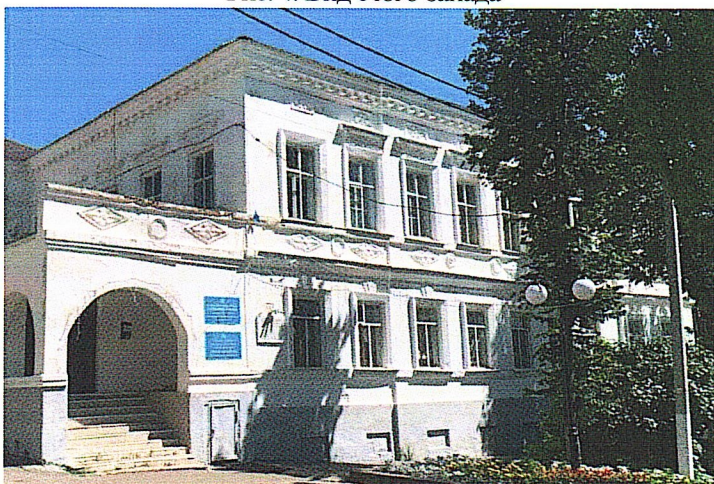
Рис.5. Вид с юго-запада
