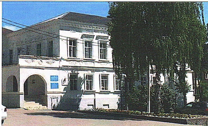
Рис. 4. Вид с юго-запада
