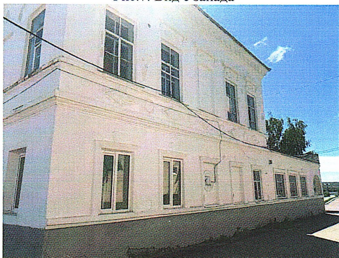
Рис.8. Вид с северо-запада
