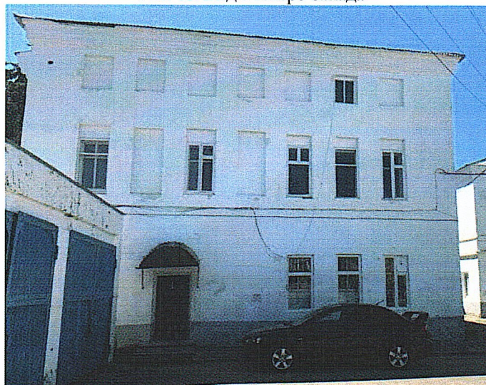
Рис. 12. Вид с севера
