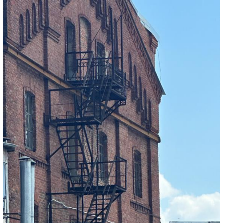
Балкон һәм баскыч
