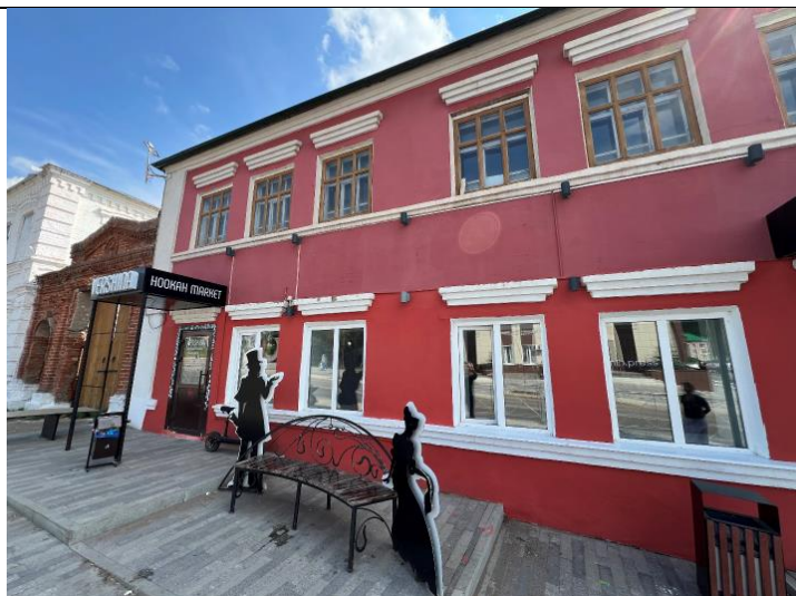
9 нчы рәсем. Тәрәзә уемнарының баскычлы тәрәзә төбөндәге кәрнизләр пояслары
