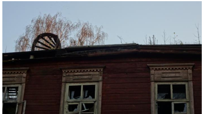
8 нче-9 нчы рәсемнәр. Бинаның түбәсе (югалган), ишетү тәрәзәсе конструкцияләре сакланган
