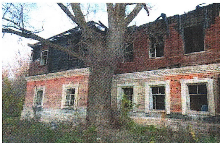
Рис. 11. Фрагмент западного фасада
