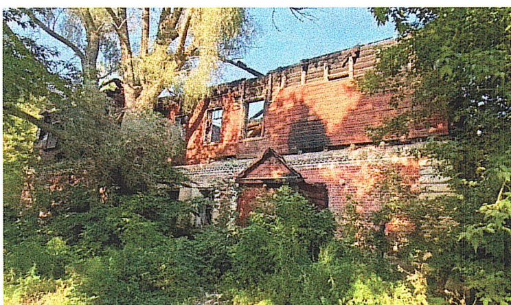
Рис. 12. Фрагмент западного фасада
