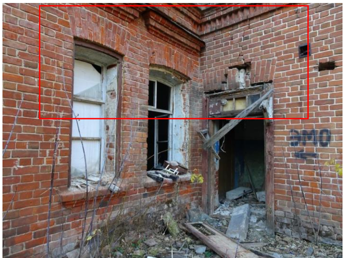
5 нче рәсем. Тәрзә һәм ишек уемнарының кирпич перемычкалары
