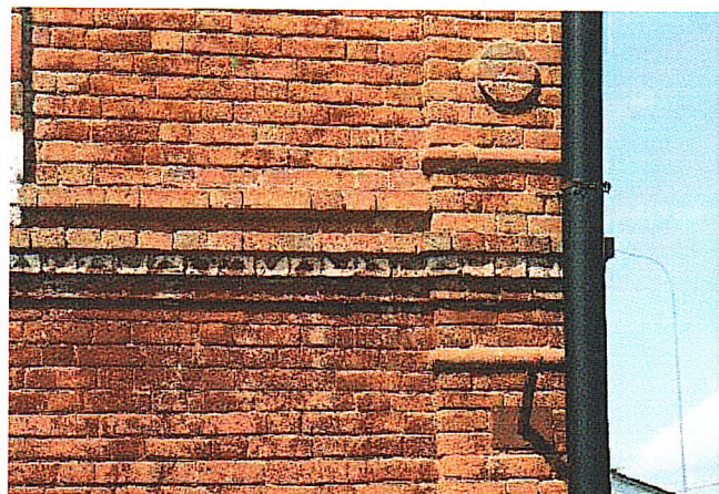
Рис. 13. Подоконный ступенчатый карниз оконных проемов второго этажа
