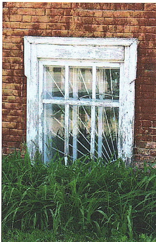
Рис. 18. Рамочные деревянные наличники оконных проемов первого этажа
