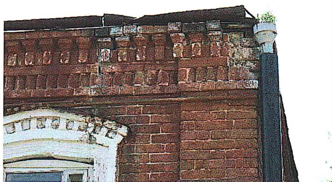
Рис. 14. Завершение кирпичного объема здания антаблементом
