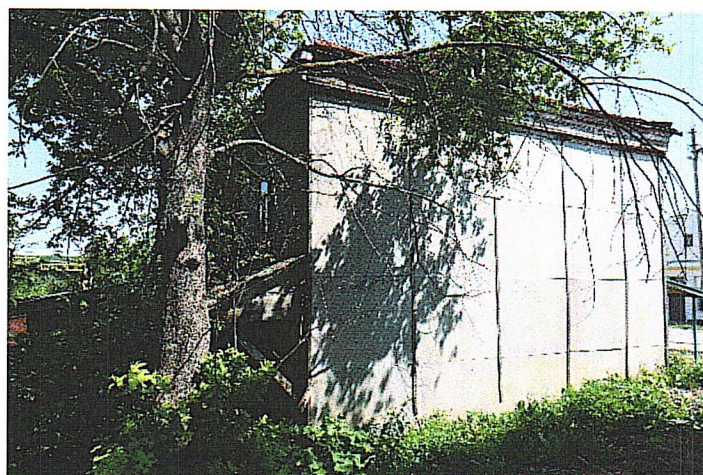
Рис. 17. Деревянный объем лестничной клетки со стороны южного фасада с завершением венчающим карнизом
