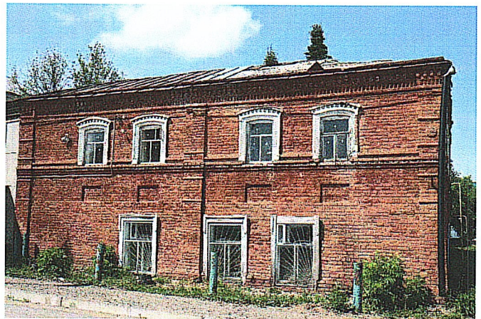
Рис. 11. Вид на фрагмент восточного фасада по ул. Космонавтов
