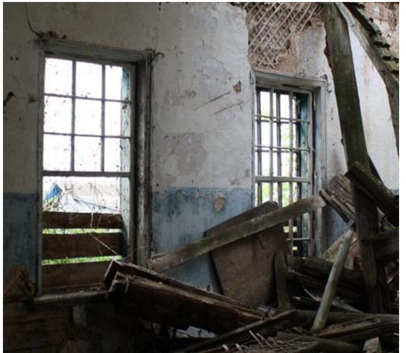
55 нче-57 нче рәсемнәр. Аш бүлмәсе һәм гыйбадәтханә өлешендәге тәрзәэ уемнарының столяр тутырылышы
