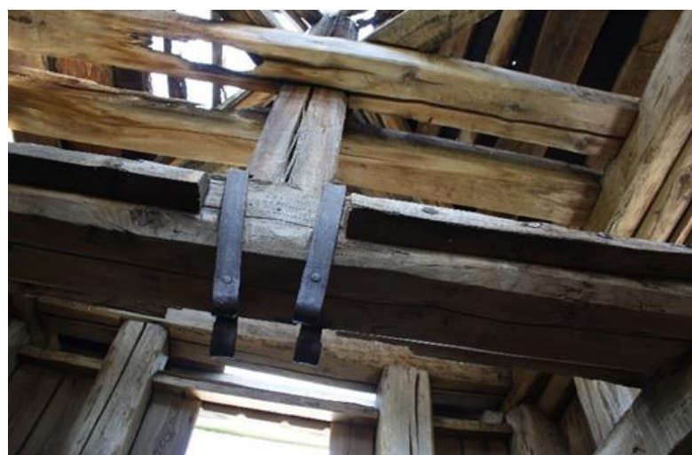
21 нче рәсем. Чаң манарасы, икенче кат. Чатыр конструкциясенең төп юнәлеш элементы фрагменты
