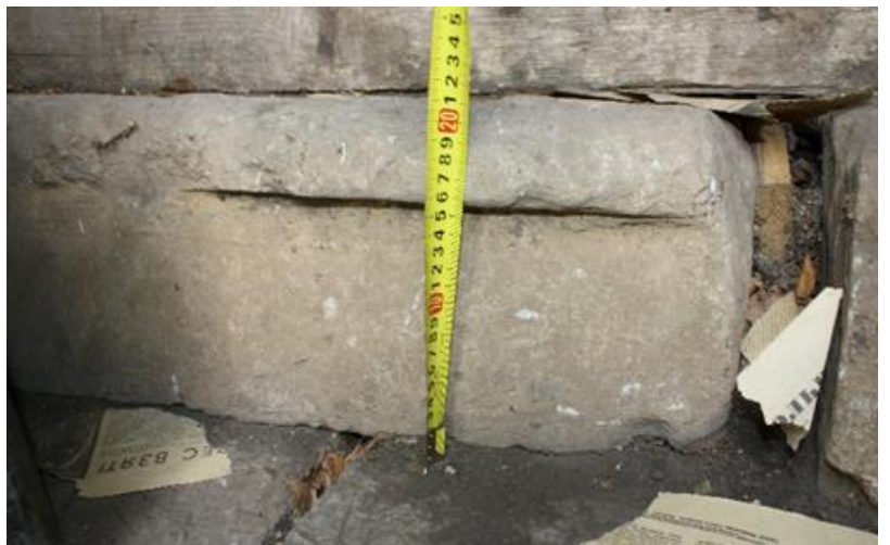
40 нчы-42 нче рәсемнәр. Көнбатыш, төньяк һәм көньяк баскычларның табигый ташыннан профильле баскычлар
