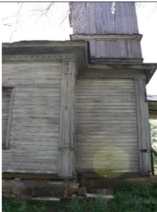
13 нче рәсем. Табигый таштан ясалган эре блоклардан өелгән нигез. Төньяк фасад фрагменты
