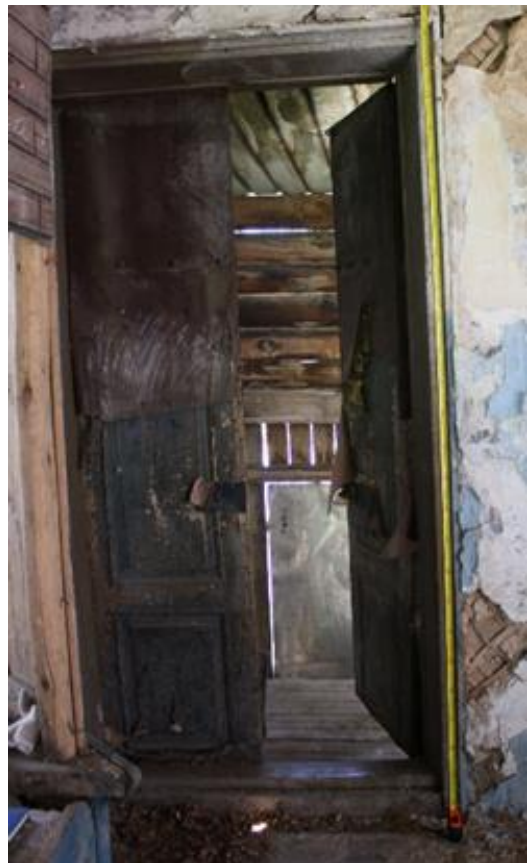
64 нче-66 нчы рәсемнәр. Гыйбадәтханә өлешендәге ишек уемнарын (төньяк һәм көньяк канатларын) филенчалы столяр тутырылышы
