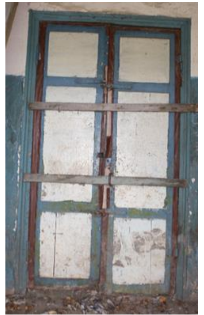
62 нче-63 нче рәсемнәр. Болдырның (манараның беренче ярус), аш бүлмәсенең ишек уемнарын филенкалы столяр тутырылышы
