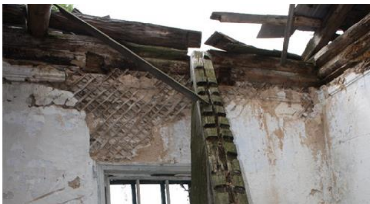
14 нче рәсем. Аш бүлмәсендә яссы агач түшәмәләр (өлешчә югалтылган). Араталарның оялары.
