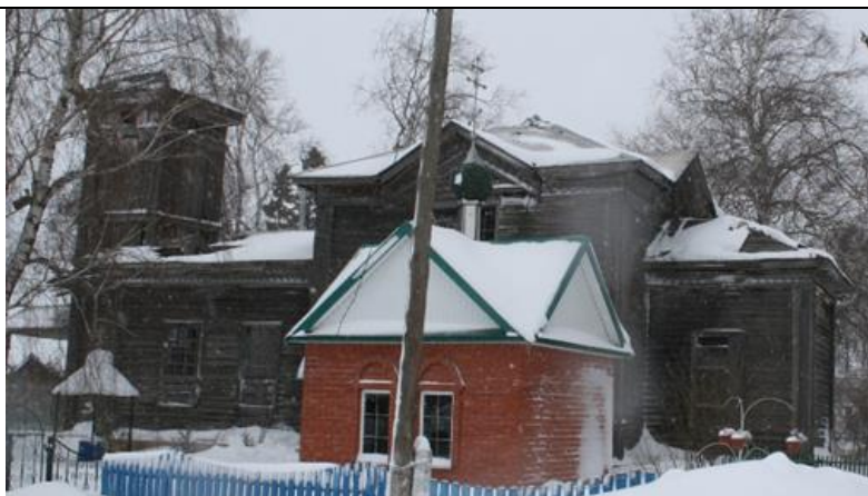
16 нчы рәсем. Гыйбадәтханә өлешенә дүрт кырлы түбәсе, күчәрләре буенча дүрт якка симметрияле урнашкан өчпочмаклы кыскачлар; сизгез кыры барабан башлығы һәм алма өстендәге тәре белән тәмамланган (югалтылган)
