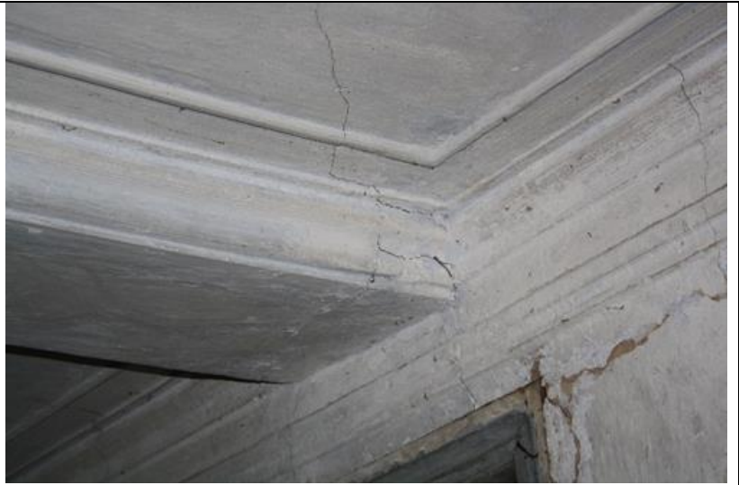
52 нче рәсем. Гыйбадәтханә өлешенә кессонлаштырылган түшәм өслекләре
