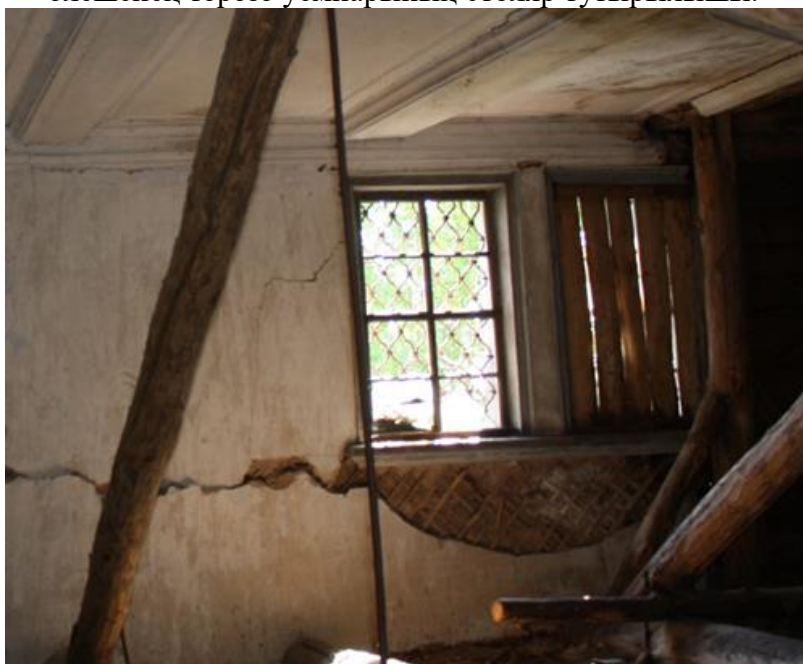
58 нче рәсем. Декоратив металл рəşətkələ храм өлешенең тәрзə уемнарының столяр тутырылышы.
