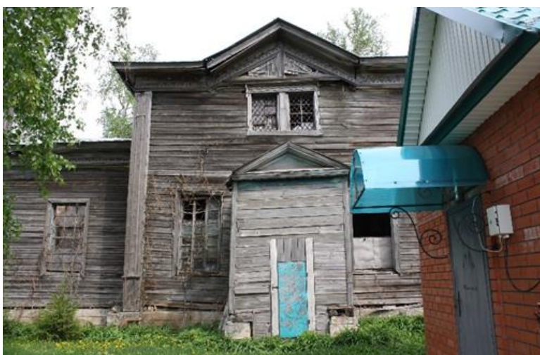
11 нче рәсем. Табигый таштан ясалган эре блоктардан өелгән нигез. Көнъяк фасад фрагменты
