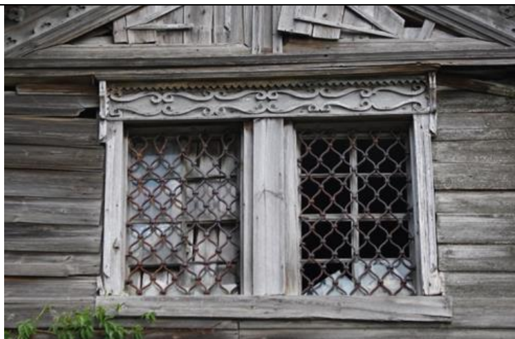
58 нче рәсем. Декоратив металл рəşətkələ храм өлешенең тәрзə уемнарының столяр тутырылышы.
