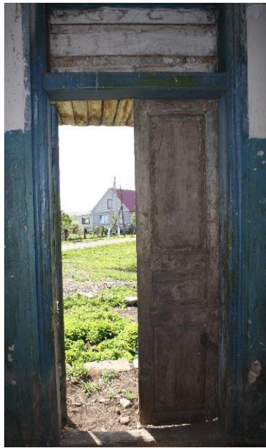
62 нче-63 нче рәсемнәр. Болдырның (манараның беренче ярус), аш бүлмәсенең ишек уемнарын филенкалы столяр тутырылышы
