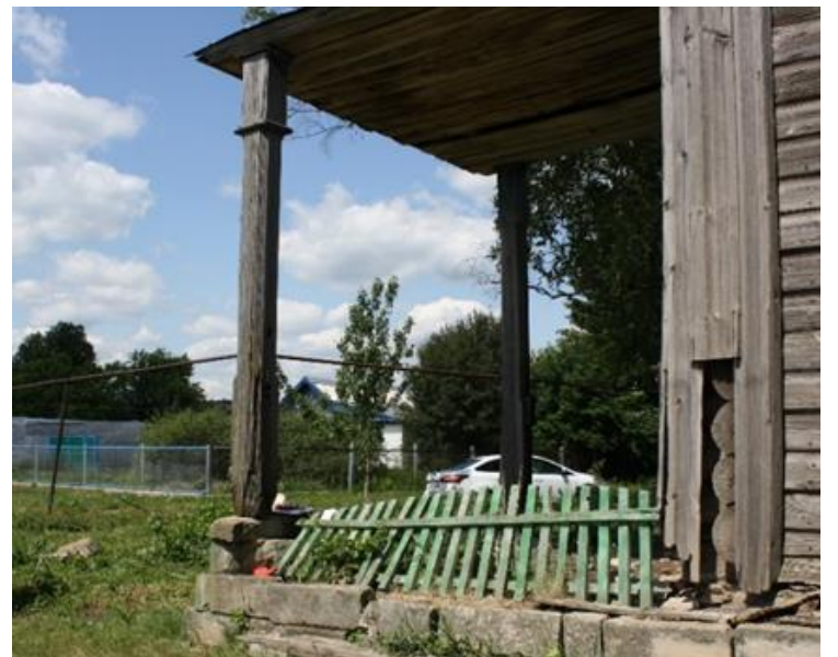
38 нче-39 нчы рәсемнәр. Пландә турыпочмаклы баганалардагы көнбатыш, төньяк һәм көньяк болдырларның декоратив профильле билбау/кәрнизләре, үзәк өлешендә тар почмаклы һәм өске өлешендә гади профильле декоратив детальләре бар
