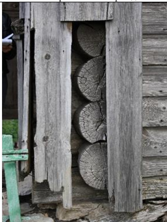
7 нче рәсем. Бүрәнәдән бура диварлар. Кыңгырау манарасының 1 нче ярусының Көнък фасады фрагменты (болдыры)
