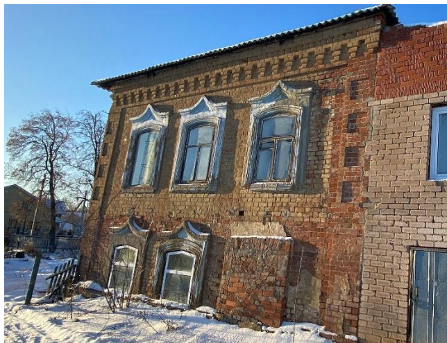
Рәсем. 24. Арткы фасадтагы тәрәзә һәм ишек уемнарының урнашу урыны, габаритлар конфигурациясе
