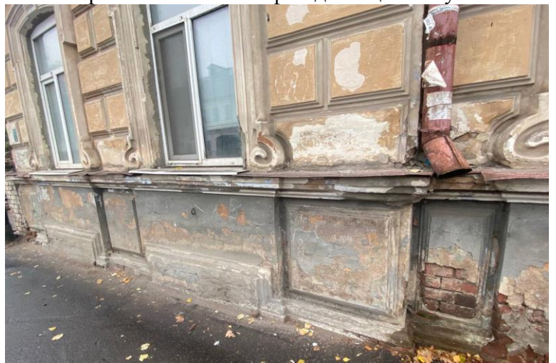
37 рәсем. Көнчыгыш фасадның профильле, филенчалы, киселешле цоколы
