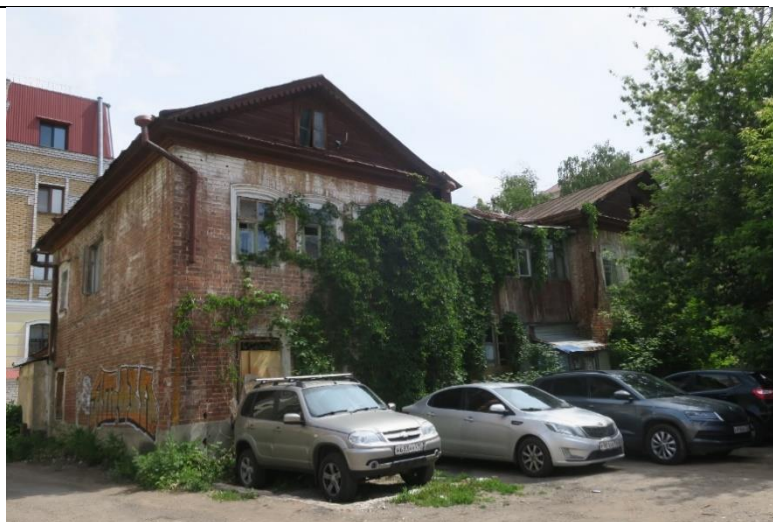
16 рәсем. Төньяк һәм көнбатыш фасады
