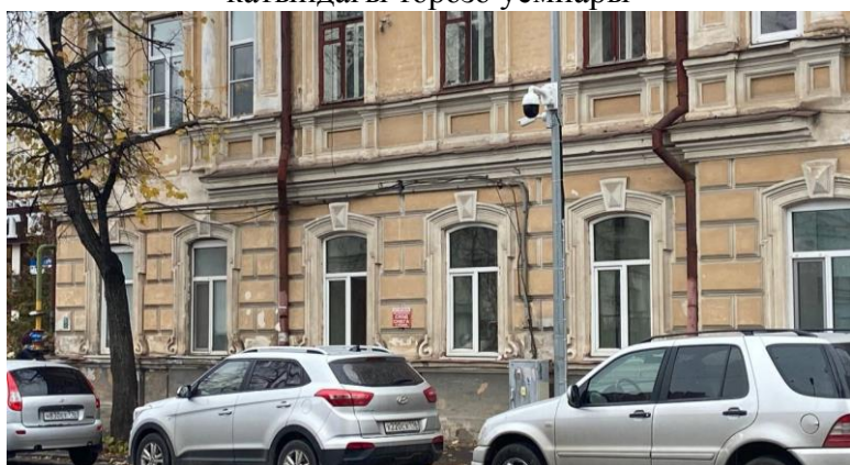
35 рәсем. Көнчыгыш фасадының беренче катындагы рустовка һәм тәрәзә уемнары
