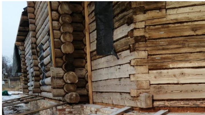
Чиркәүнең көнъяк-көнчыгыш бүрәнәле диварлар, апсида һәм дүртле диварлар
