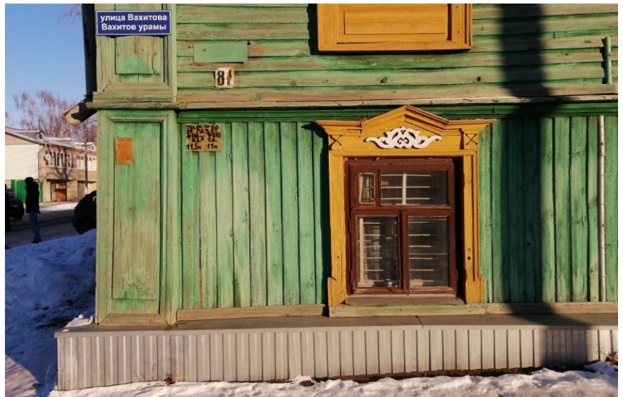
14 рәсем. Ян фасад фрагменты. Беренче катның тәрәзә уемын, почмаклары бизәкләре
