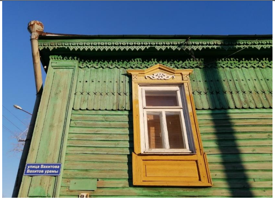
13 рәсем. Ян фасад фрагменты. Тәрәзә уемы, карнизе һәм фризы тәмамлаучы икенче катның почмагы бизәкләре
