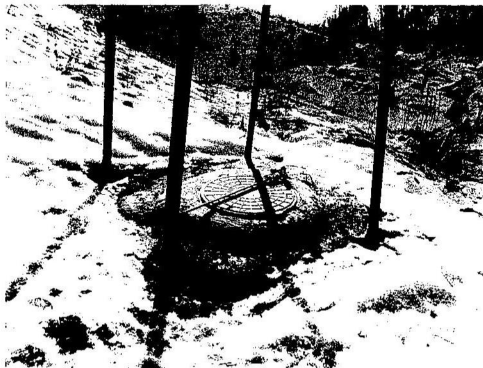
Рис. 8. Люк над канализационной камерой
