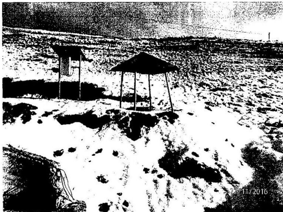
Рис.7 . Каптажное сооружение водозабора «Чабки-Сабы»
