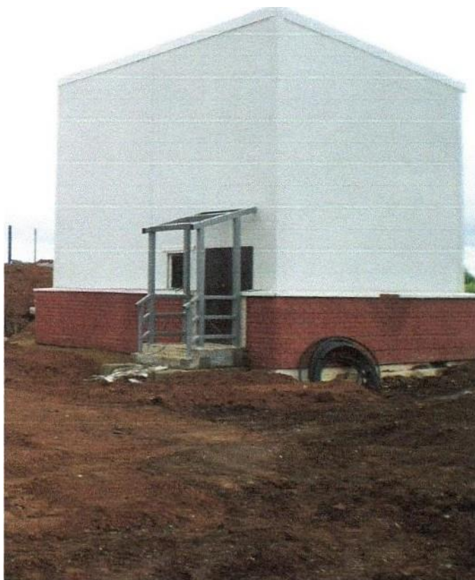
1 нче фото. Насос станциясе бинасы
