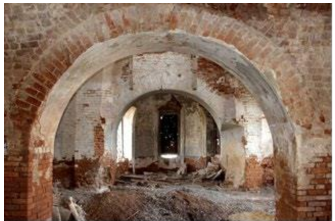
Кафоликонның апсида һәи ашау-эчү бүлмәләренең анфилад-бәйлә бүлмәләре
