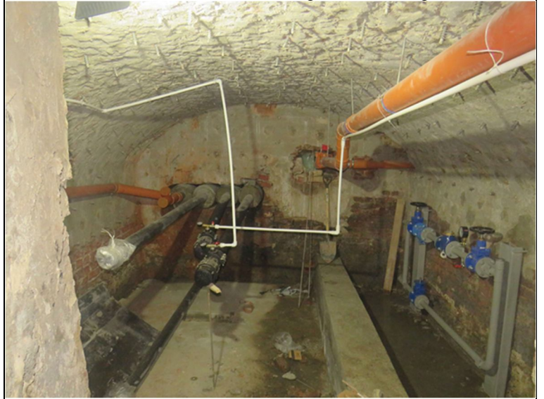
Подволдагы үзек ишек астындагы кирпич гөмбәзләр
