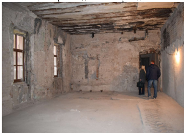
«Монье» рэвешендэге катара түшэмэ (чын түшэмэлэр юкка чыккан)
