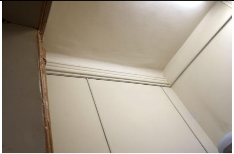
Подвал каты бинасында түшәм тягасы профиле
