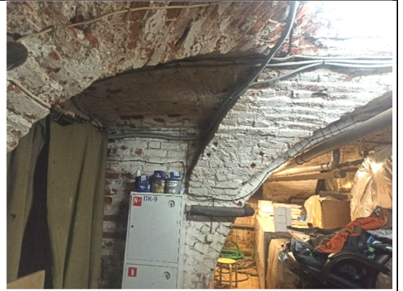
Подвал бинасында кирпеч цилиндрик гөмбәзләр
