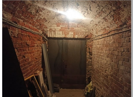
Подвал бинасында кирпеч цилиндрик гөмбәзләр
