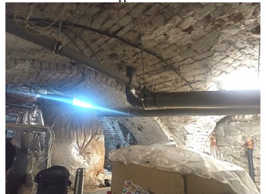
Подвал бинасында кирпеч цилиндрик гөмбөзләр
