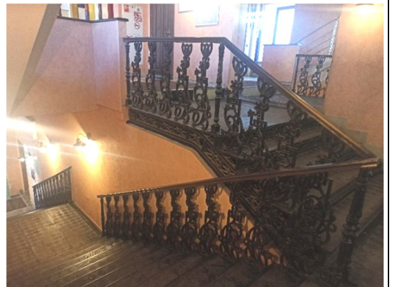
1 нче һәм 2 нче кат биналарын тоташтыра торган чуен баскыч
