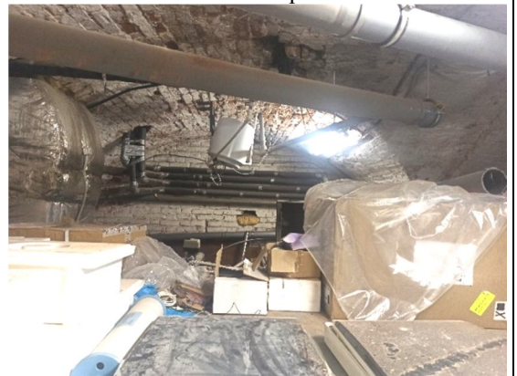
Подвал бинасында кирпеч цилиндрик гөмбөзләр
