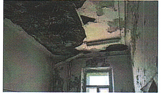
Рис.11. Междуэтажные плоские перекрытия, кирпичные перемычки оконных проемов
