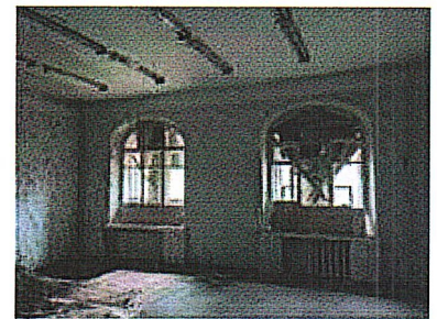
Рис.8. Междуэтажные плоские перекрытия, кирпичные перемычки оконных проемов
