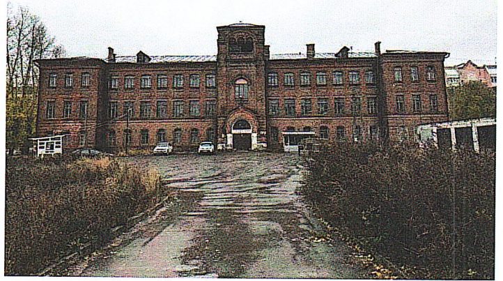
Рис.48. Общий вид на здание
