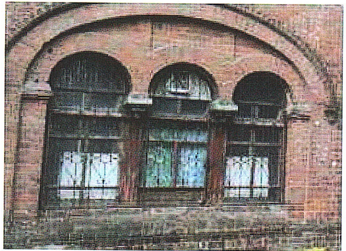
Рис.49. Оконные заполнения первого этажа храмовой части
