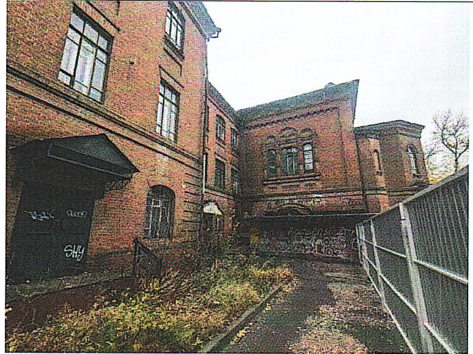
Рис.3. Общий вид с юго-востока
