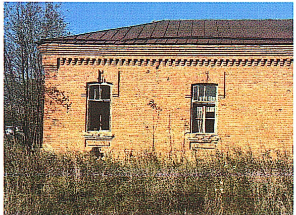
Рис.15. Фрагмент юго-западного фасада
