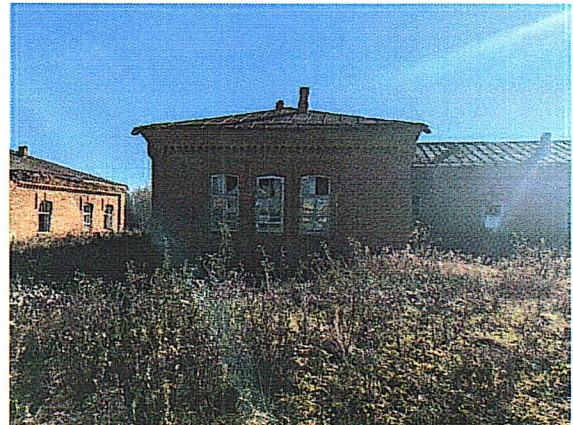
Рис.14. Фрагмент северного фасада
