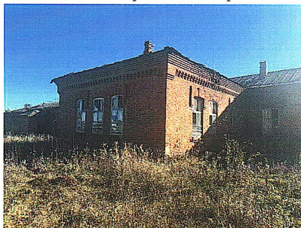
Рис.11. Фрагмент северного фасада
