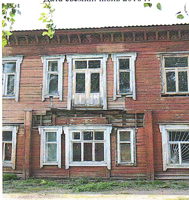
Рис.14. Фрагмент северо-западного фасада. Центральная часть (местоположение утраченного балкона). Дата съемки: июль 2016 г.
