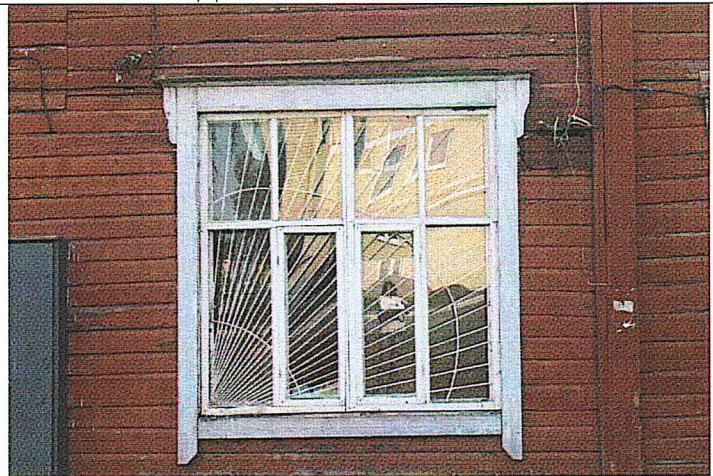
Рис.13. Фрагмент юго-западного фасада. Оконный проем 1 этажа. Дата съемки: июль 2016 г.
