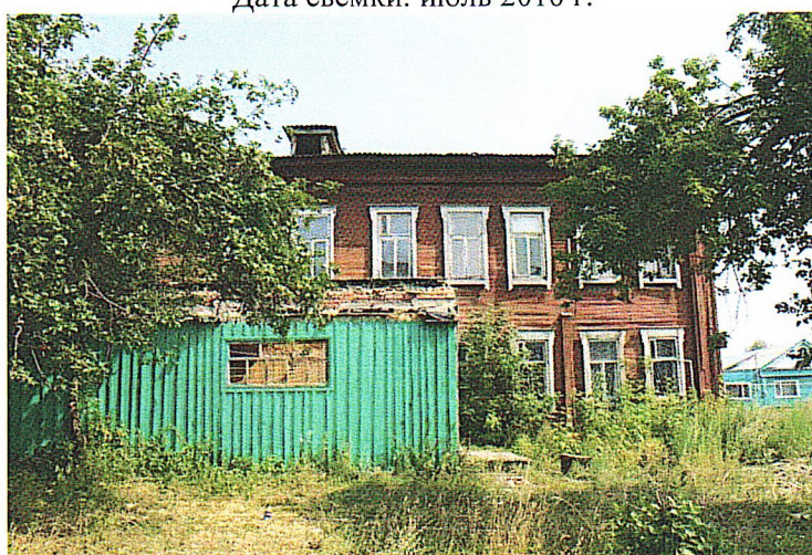
Рис.10. Юго-восточный (дворовый) фасад. Дата съемки: июль 2016 г.
