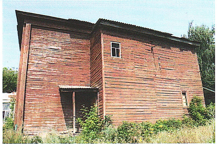
Рис.12. Северо-восточный (дворовый) фасад. Дата съемки: июль 2016 г.
