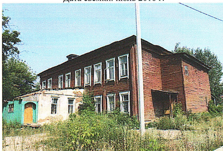
Рис.11. Юго-восточный (дворовый) фасад. Дата съемки: июль 2016 г.
