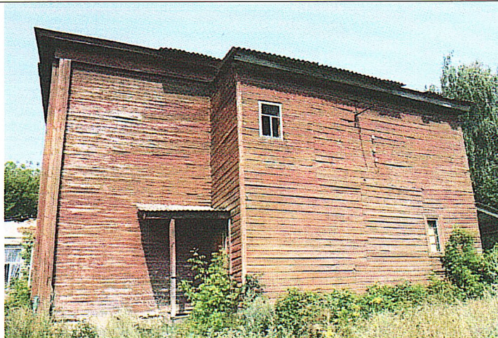
Рис.12. Северо-восточный (дворовый) фасад. Дата съемки: июль 2016 г.
