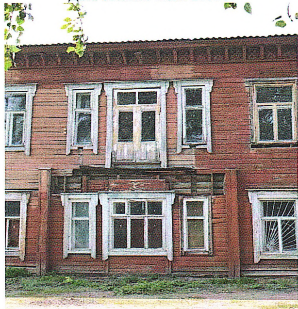
Рис.14. Фрагмент северо-западного фасада. Центральная часть (местоположение утраченного балкона). Дата съемки: июль 2016 г.
