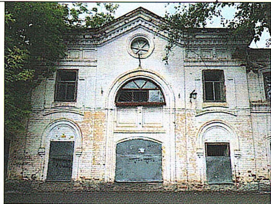
Рис.13. Кирпичная кладка главного фасада.
