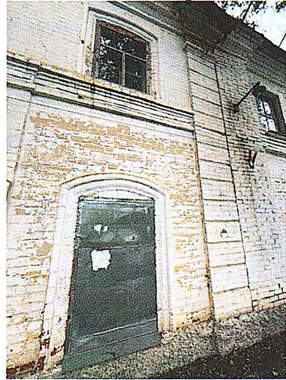
Рис.8. Заполнение оконных проемов.
