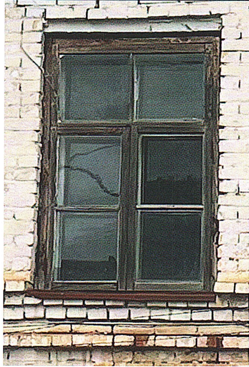
Рис.12. Заполнение оконных проемов.
