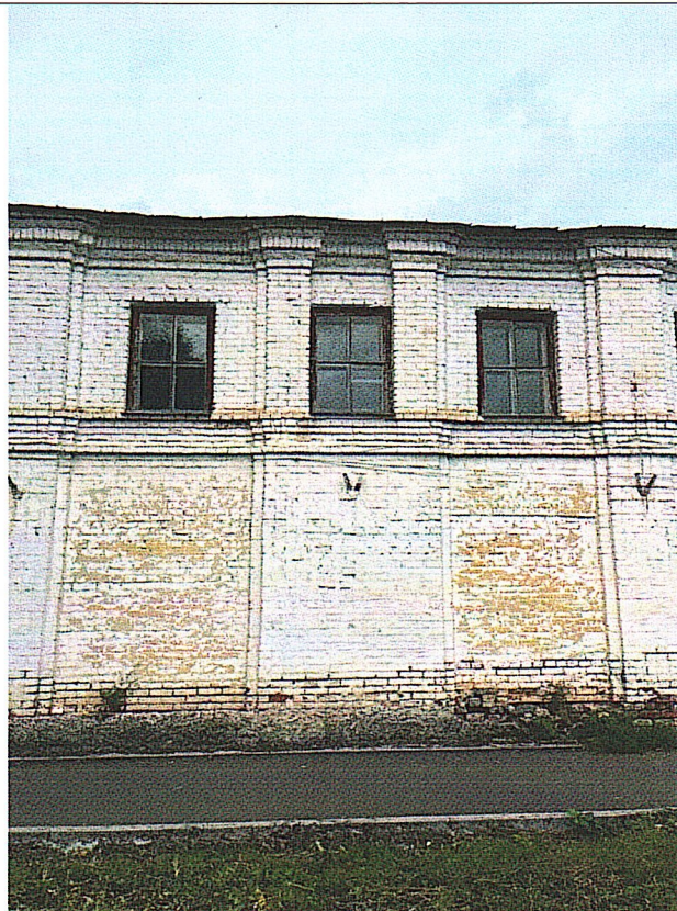
Рис. 10. Отделка фасадной поверхности.
