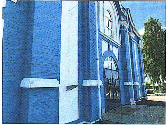
Рис. 10. Вид с севера
