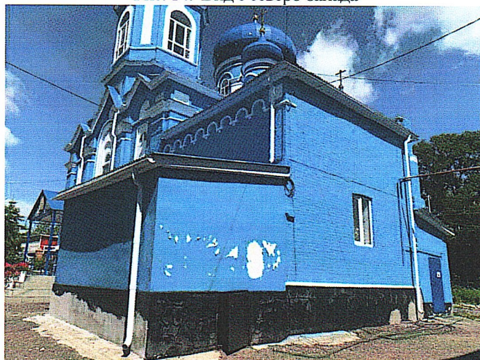
Рис. 15. Вид с юго-запада
