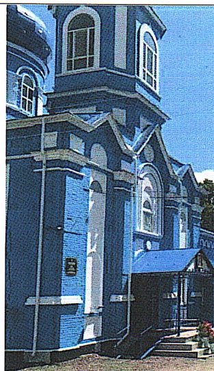
Рис. 4. Вид с северо-запада
