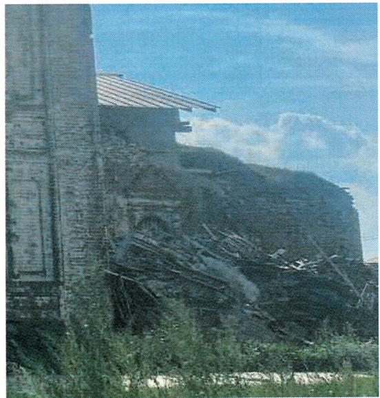
Рис.4. Вид с севера
