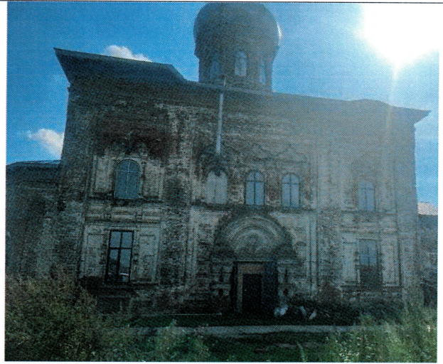
Рис.9. Вид с севера
