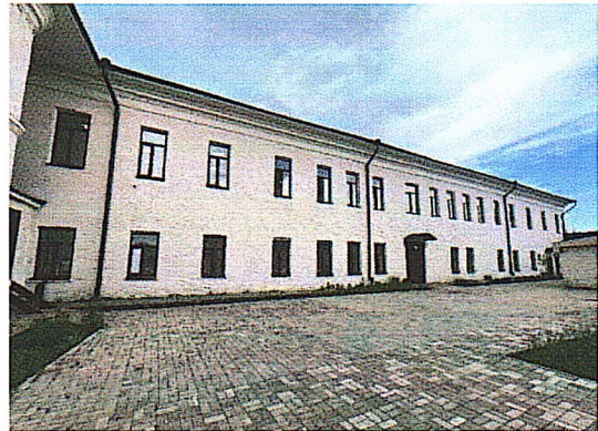
Рис. 15. Общий вид со стороны двора.
