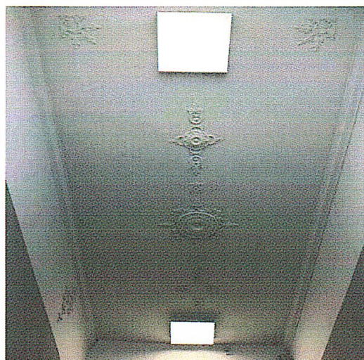
Рис. 18. Лепные розетки в помещении служебной лестницы (потолок и стены).
