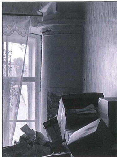
Рис. 17. Круглая печь в металлическом футляре
