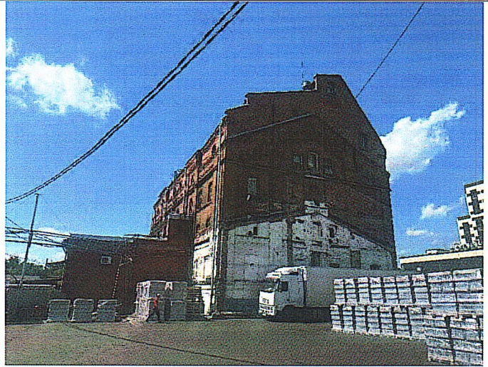
Вид с северо-восточной стороны
