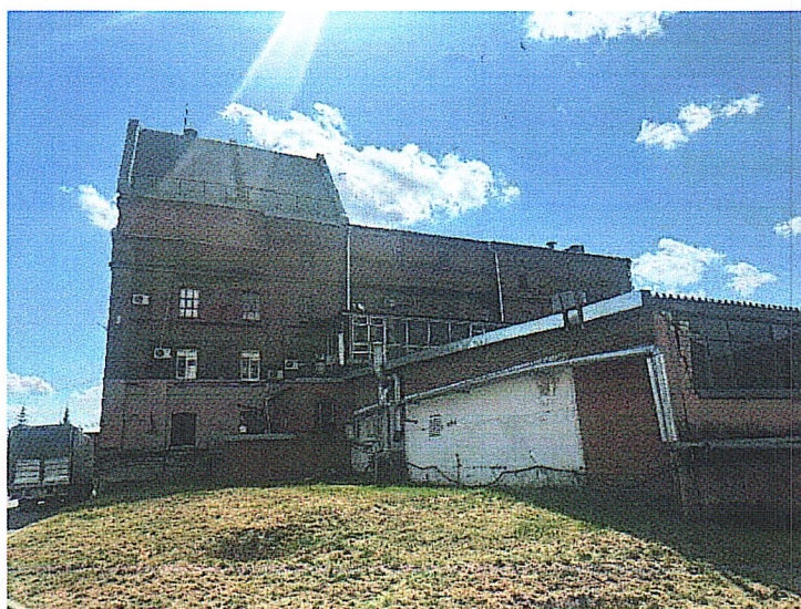
Рис. 5. Вид с западной стороны
