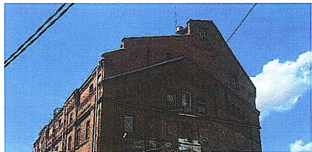
Рис. 16. Оконные проемы верхних этажей
