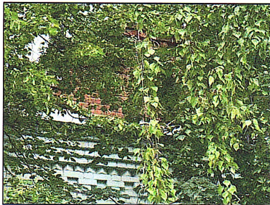
Рис. 11. Фрагмент кирпичной стены
