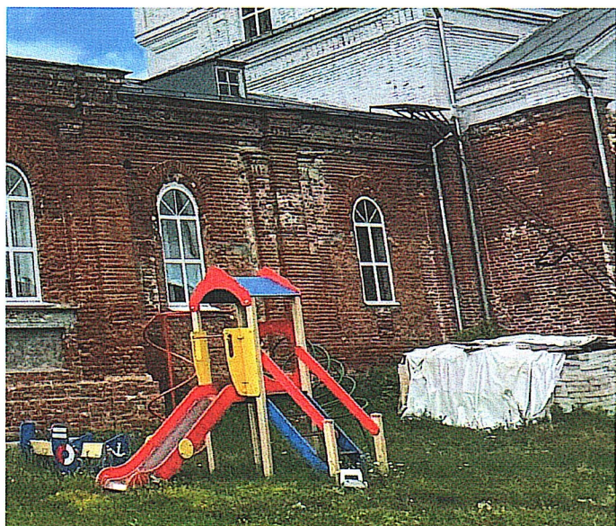
Рис. 6. Вид с севера
