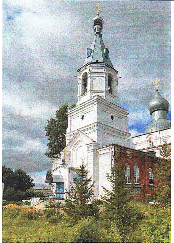
Рис. 3. Вид с юго-запада
