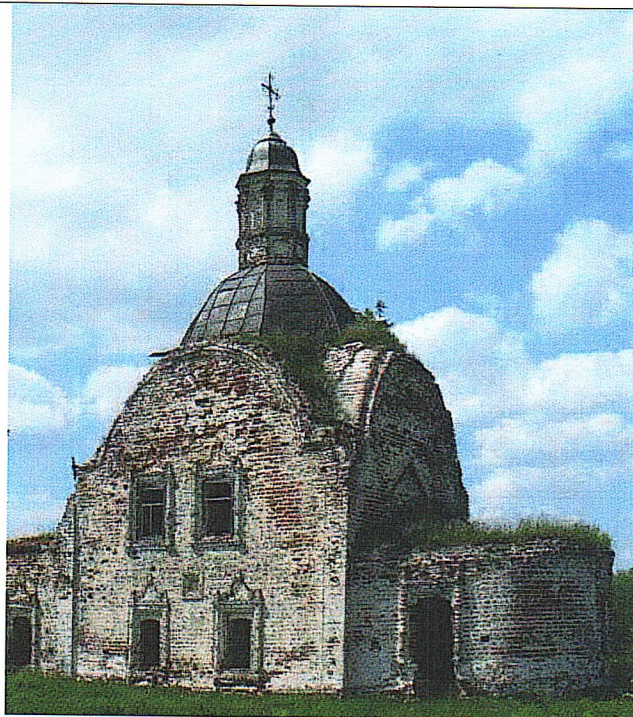
Рис. 13. Вид с юго-востока
