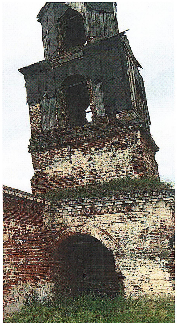
Рис. 6. Вид с севера
