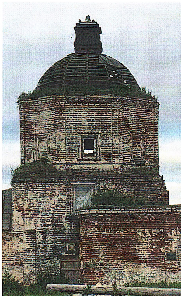
Рис. 12. Вид с севера
