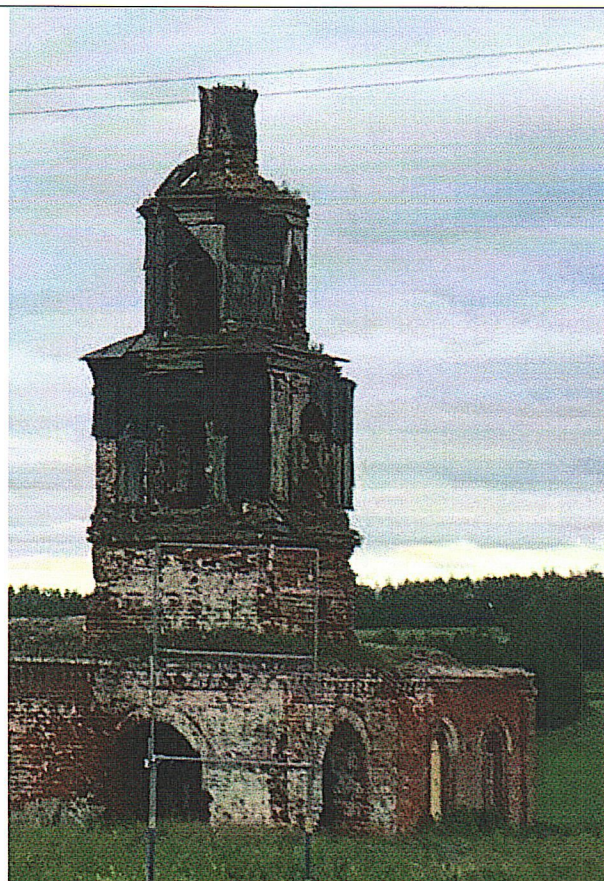
Рис. 3. Вид с юго-запада
