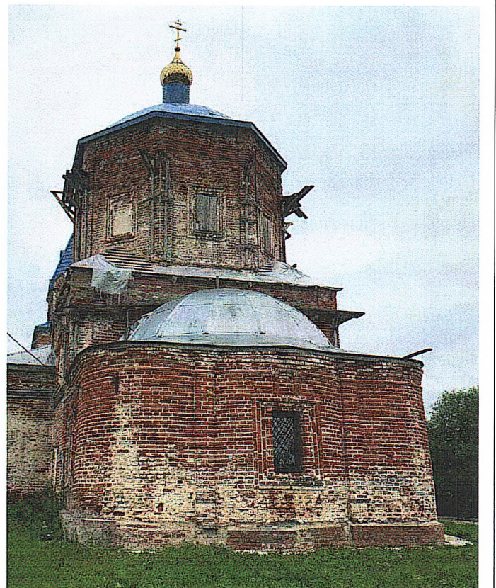
Рис. 12. Вид с северо-востока
