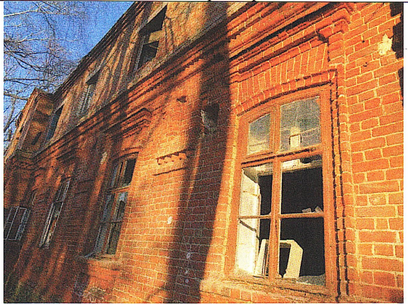
Рис. 13. Фрагмент западного фасада
