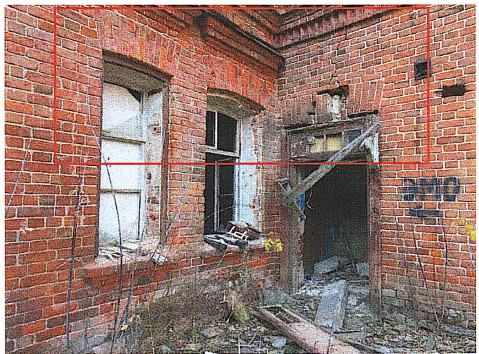
Рис. 5. Кирпичные перемычки оконных и дверных проемов
