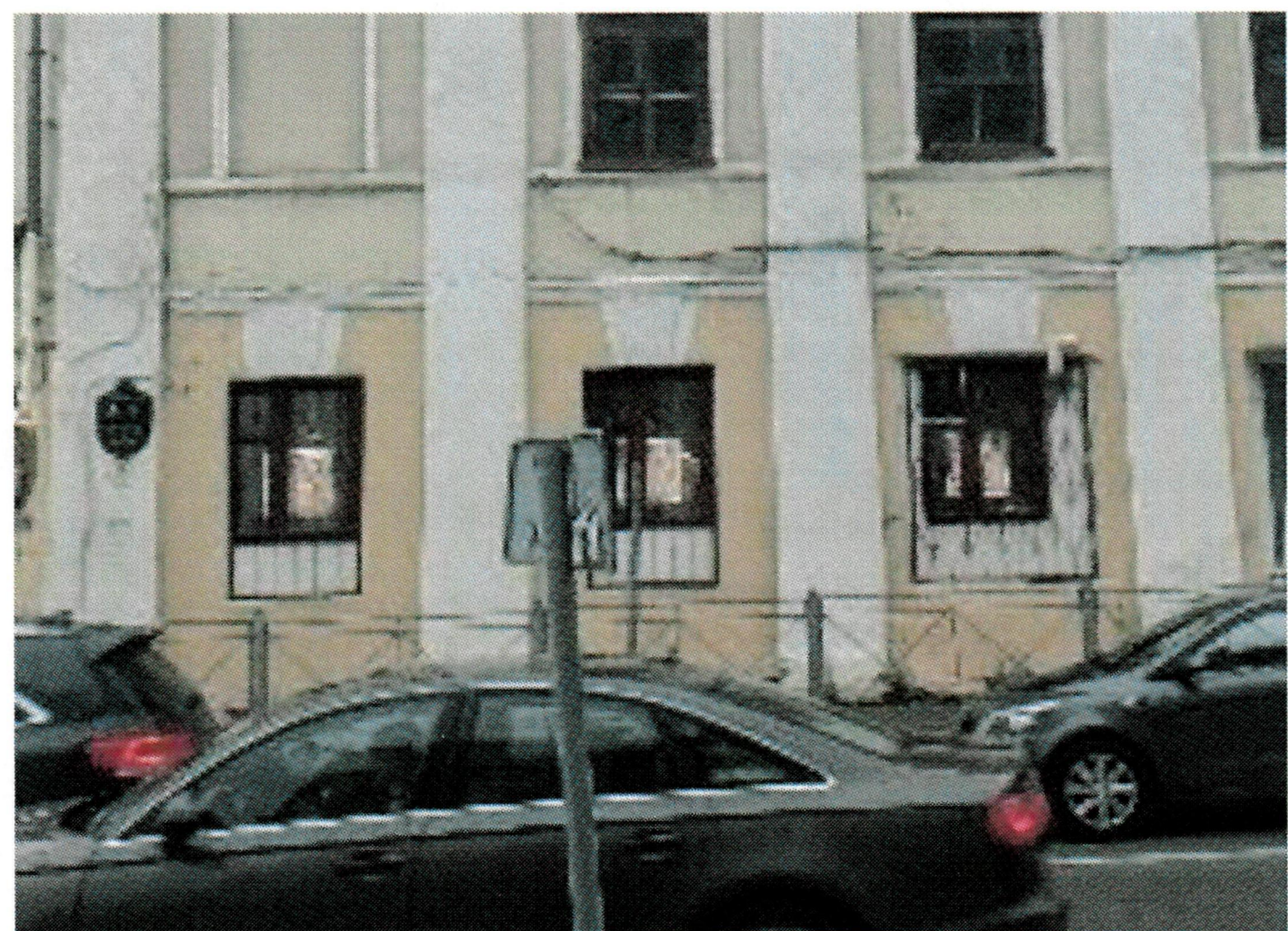
Рис. 10. Оконные проемы первого этажа
