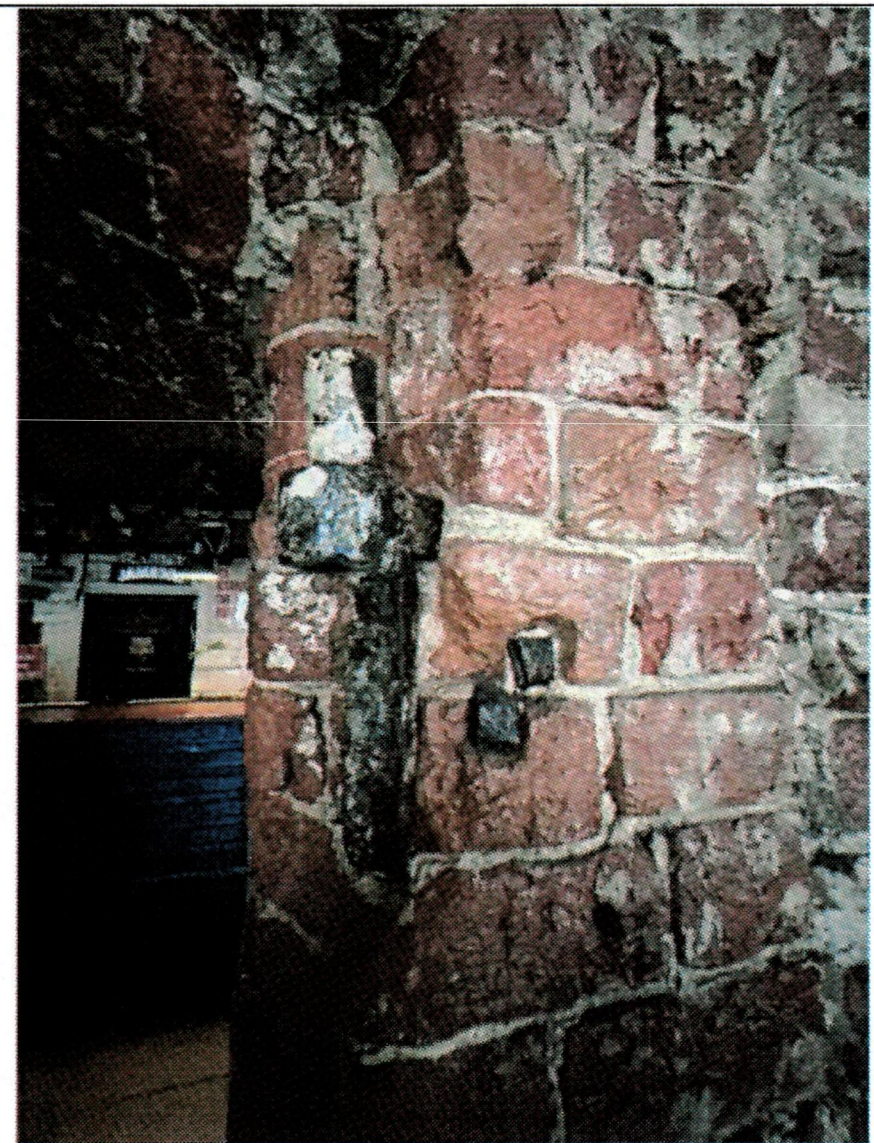
Рис. 26. Металлические кулачки в проемах первого этажа
