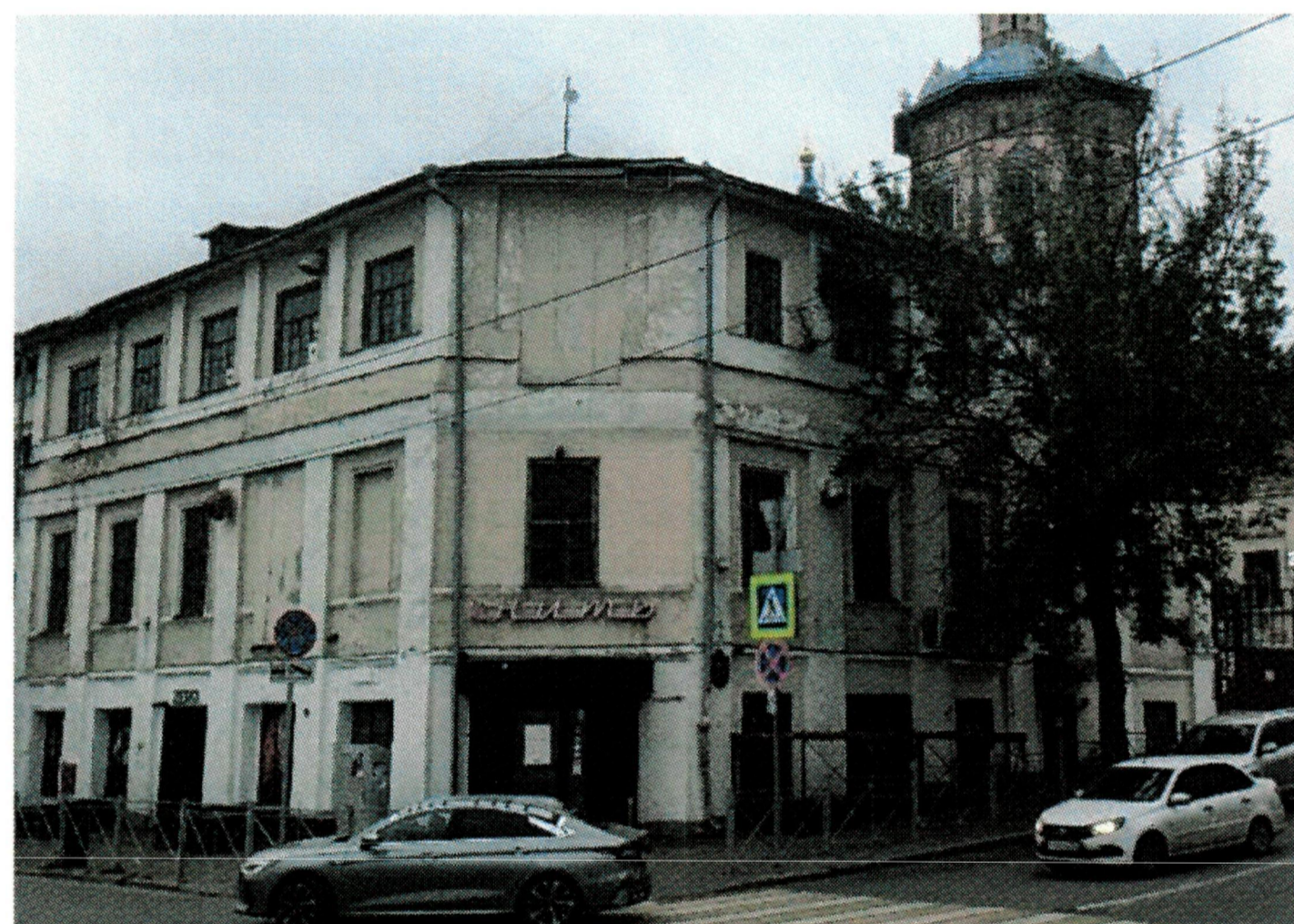
Рис. 14. Оконные проемы 1 этажа
