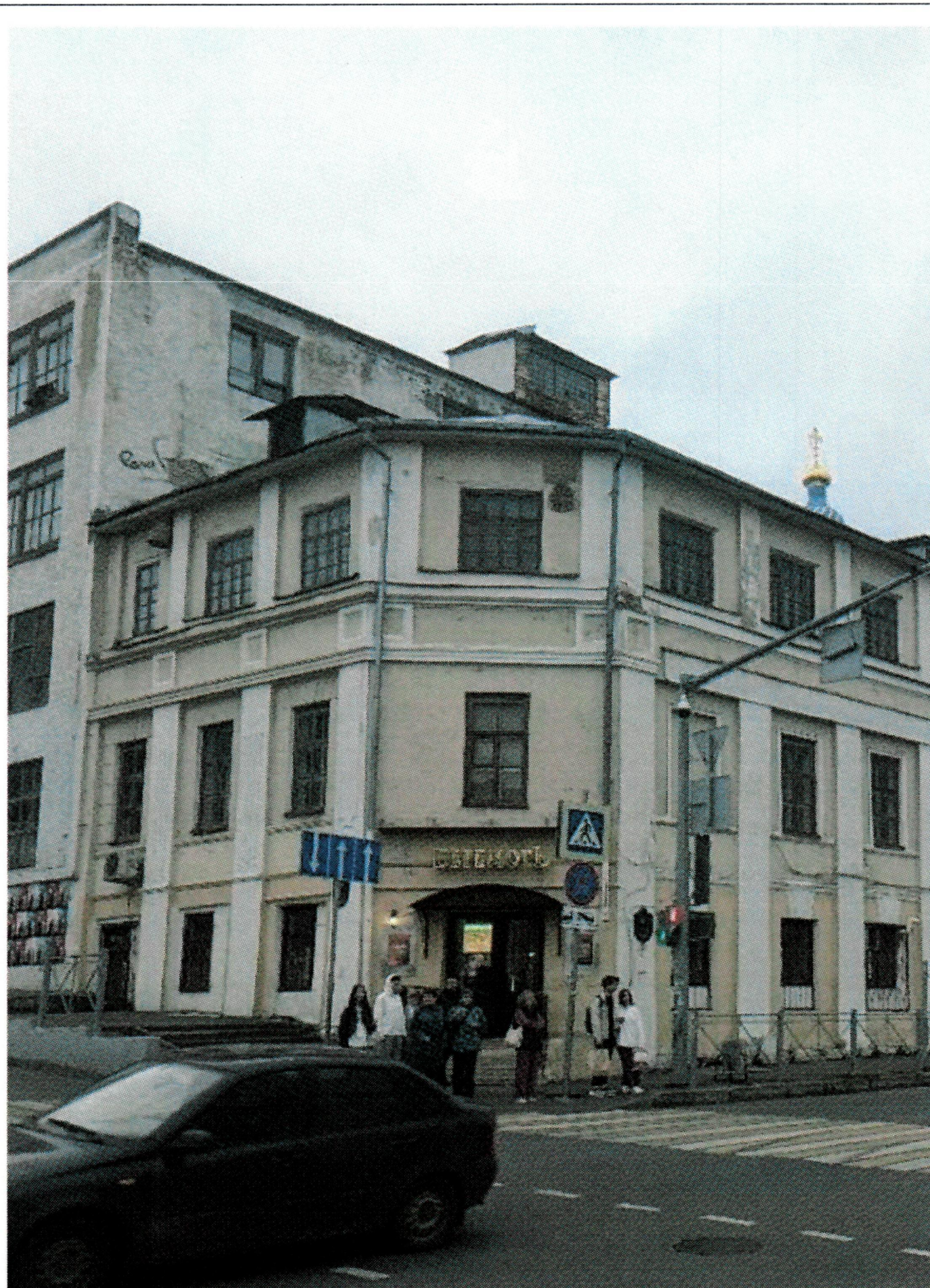
Рис. 11. Фрагмент фасада по ул. Чернышевского
