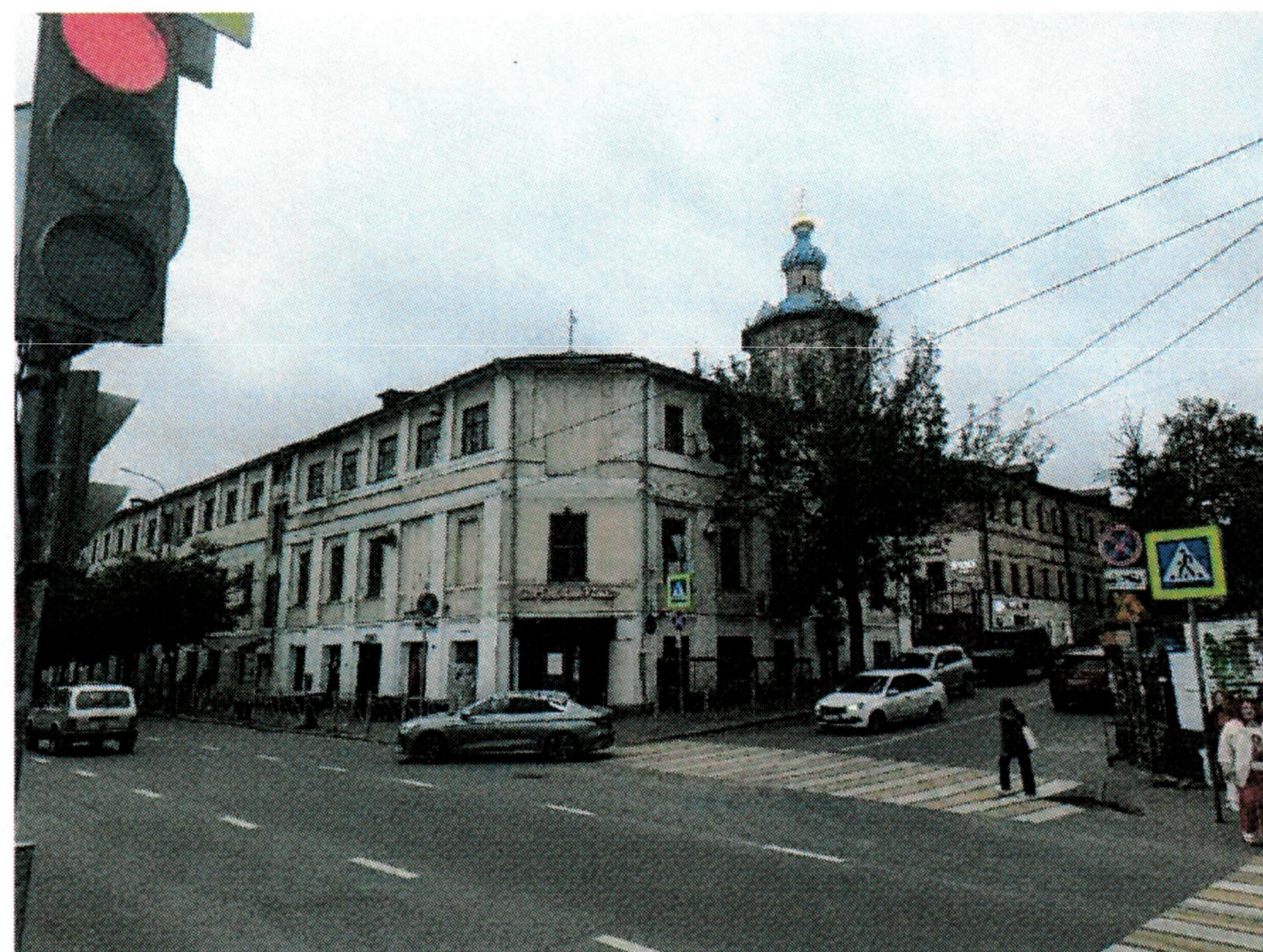
Рис. 13. Вид на фасад по ул. Чернышевского
