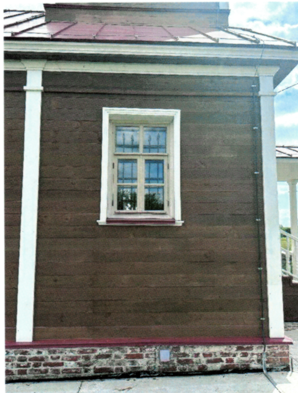
Характер оформления столярных заполнений оконных проемов, профильных наличников, кованых оконных решеток. Вид на западный фасад колокольни
