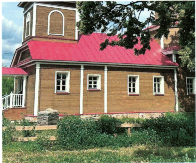
Рустованная лопатка южного фасада трапезной
