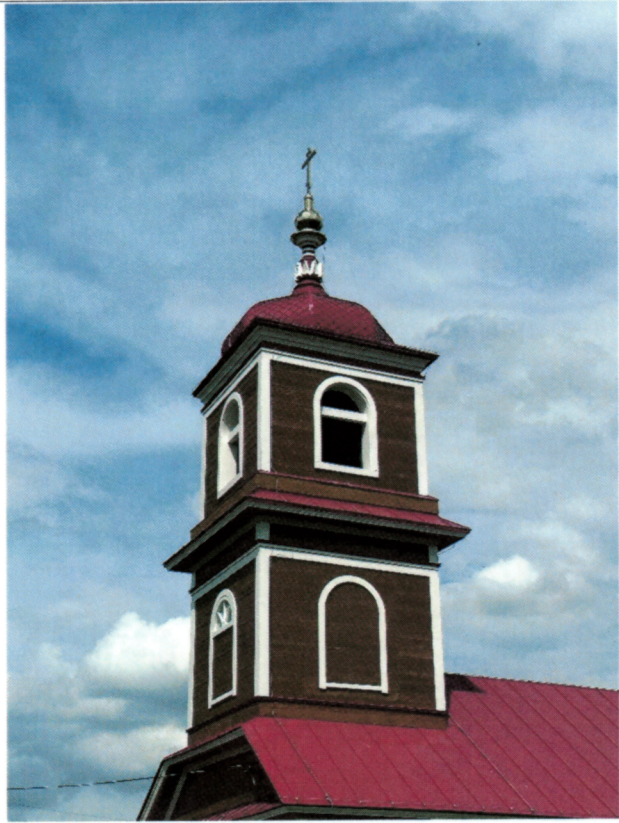
Местоположение оконных проемов сплошного заполнения и полукруглой открытой части на западном фасаде колокольни
