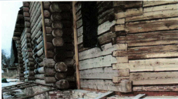
Бревенчатые стены, уложенные в «лапу», апсиды и четверика с юго-восточной части церкви
