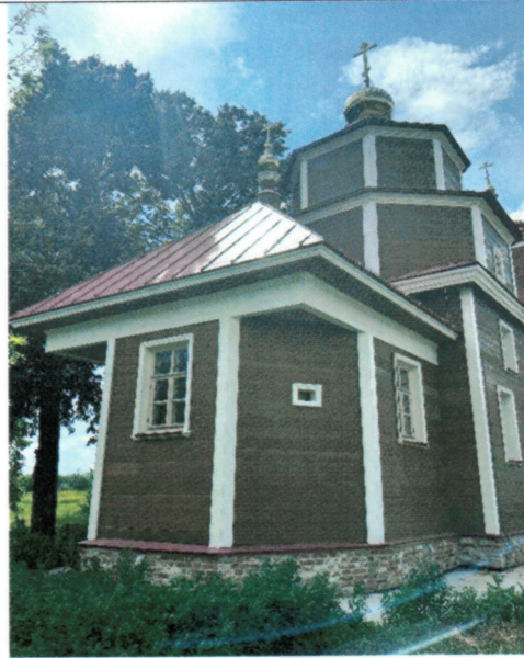
Вид с востока на апсиду
