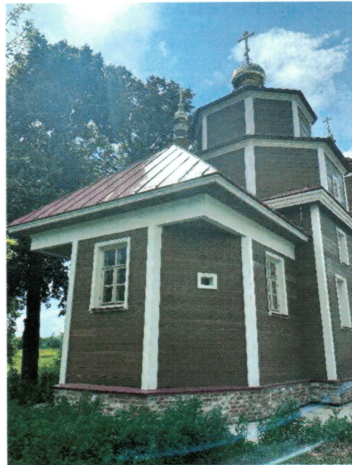
Местоположение оконных проемов апсиды
