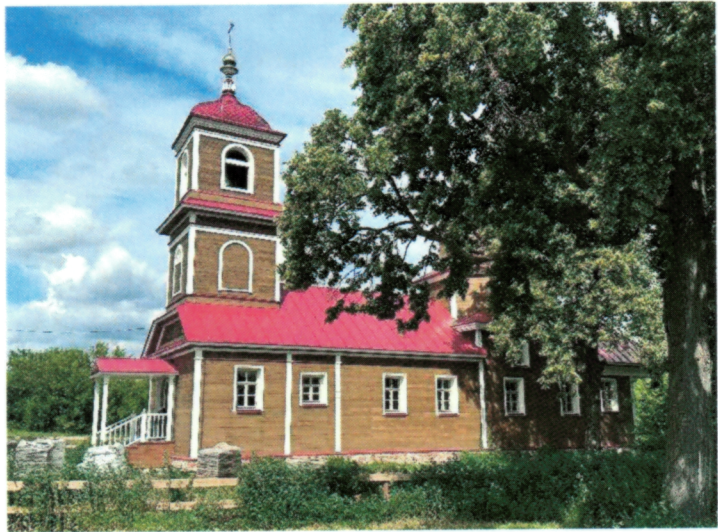
Вид с юго-запада на трапезную
