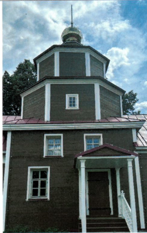
Местоположение оконных проемов восьмериков церкви
