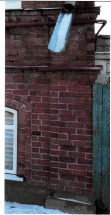
Рис. 13. Оформление угловой лопатки 1-го этажа
