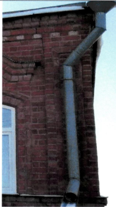
Рис. 12. Оформление угловой лопатки 2-го этажа
