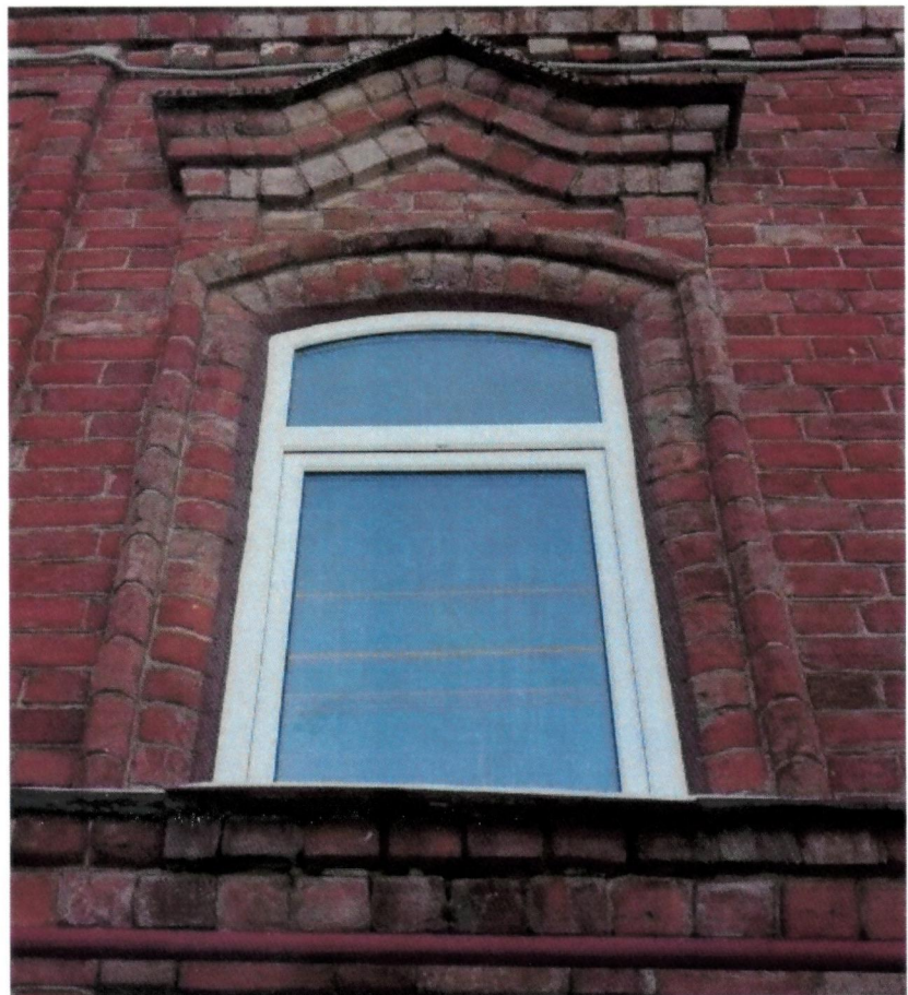
Рис. 11. Оформление оконного проема 2-го этажа
