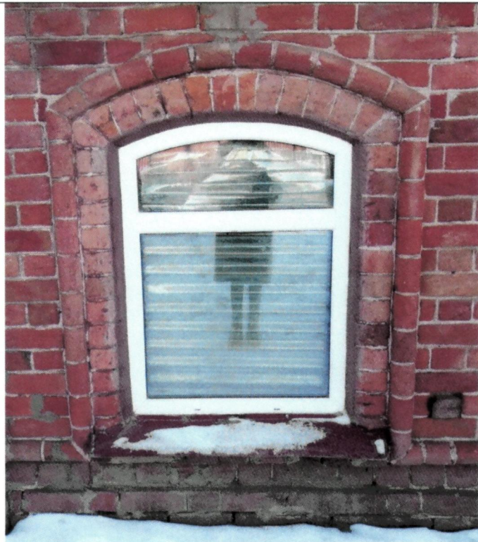
Рис. 10. Оформление оконного проема 1-го этажа
